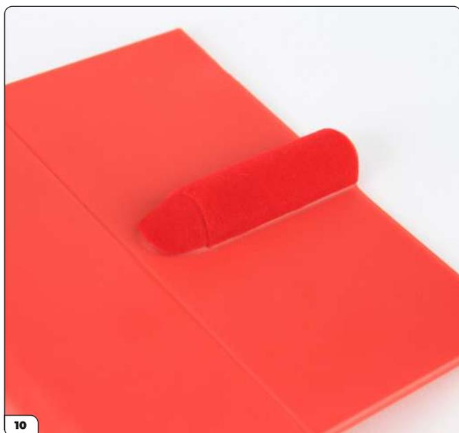
Appuyez fermement sur les moquettes et lissez les bords au niveau de la jonction.
